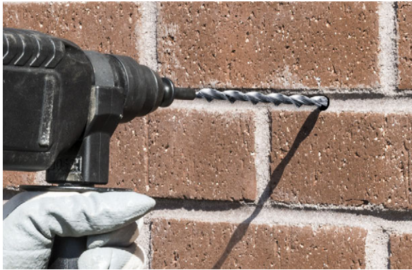
Heli-Tie Helical Wall Tie
