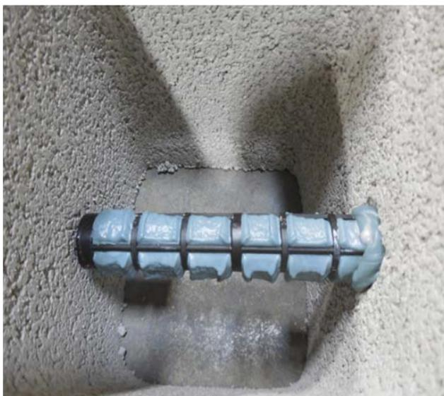
Los agujeros especialmente dimensionados en las mallas Opti-Mesh permiten que el adhesivo se filtre en el lugar adecuado de la sección hueca de las CMU (concrete masonry units, unidades de mampostería de concreto) para mejorar la adhesión a la capa protectora.
