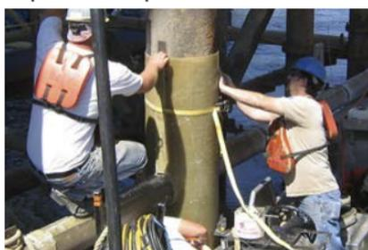
Sistema de protección y reparación de pilotes estructurales FX-70®
